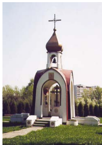
Сборная монолитная часовня строящегося храма
