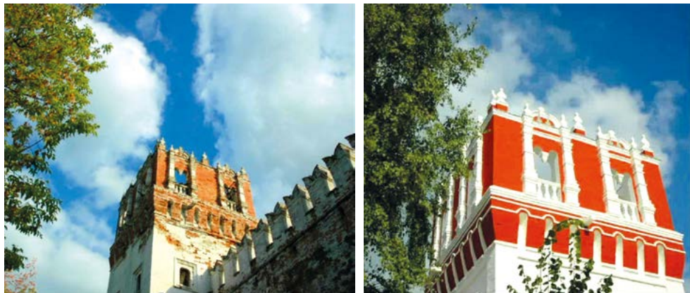
Монастырская стена до и после вычинки кирпичной кладки
