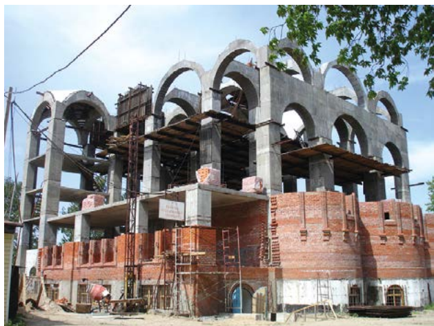
Бетонный каркас и кирпичные стены
