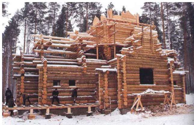
Сруб из бревен, сваленных вручную
