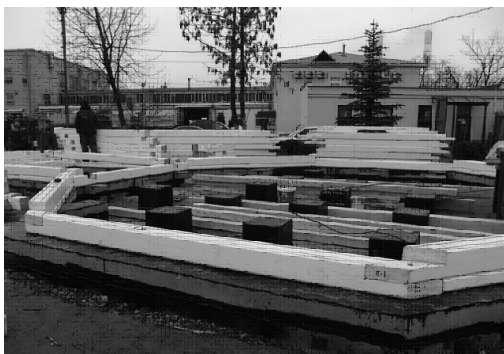
Монолитный фундамент храма
