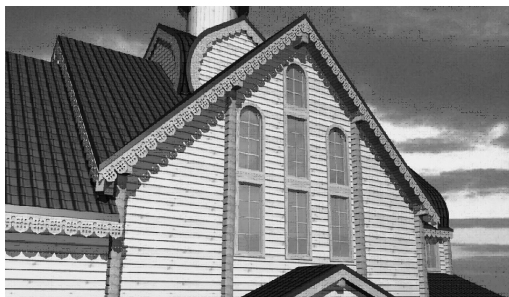
Фрагмент стены с подзорами
