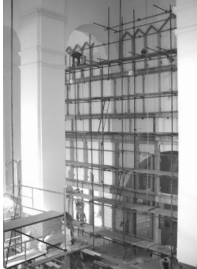
Железобетонный столб, обложенный кирпичом
