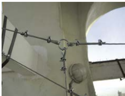
Узел крепления оттяжки стального троса, предотвращающий его излом
