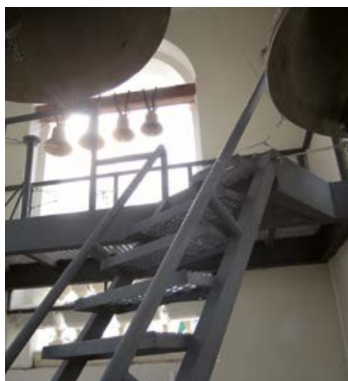
Лестница на помост звонаря, расположенная под углом в створе двух больших благовестников
