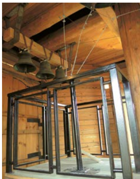
Оборудование помоста звонаря внутри деревянной колокольни
