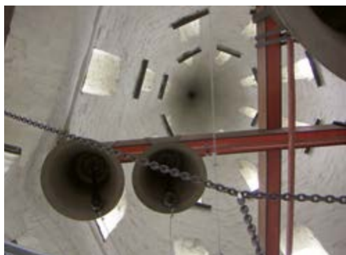
Крепление колоколов на центральной крестовине балок колокольней
