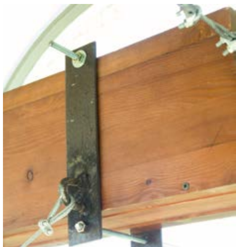
Крепление подвижной тросовой тяги к балке колокольни без вмешательства в конструкцию колокольни
