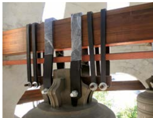
«Матичная» сложная система подвески тяжелого колокола на балке колокольни
