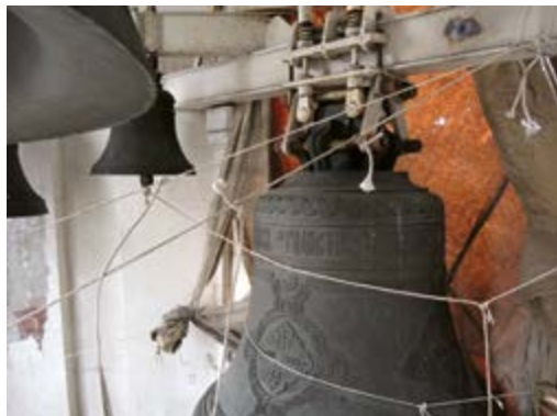
Монтаж макетной системы управления звона (шнур)
