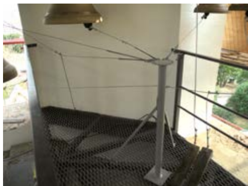
Полностью смонтированная постоянная система управления звоном и помост звонаря
